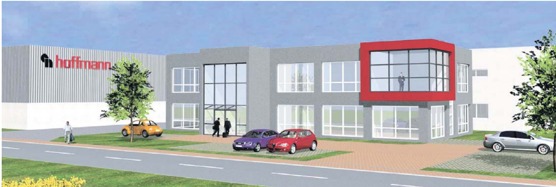
So soll der Neubau im Gewerbegebiet Hohenacker im kommenden Frühjahr aussehen. 350 Beton-Fertigteile mit einem Gewicht von 2500 Tonnen werden verbaut.
